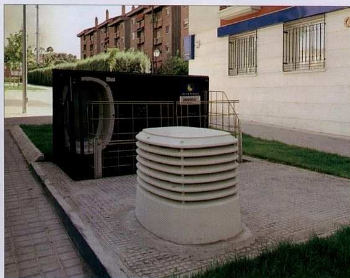
Fot. 5. Przykładowe rozwiązanie podziemnej stacji transformatorowej
